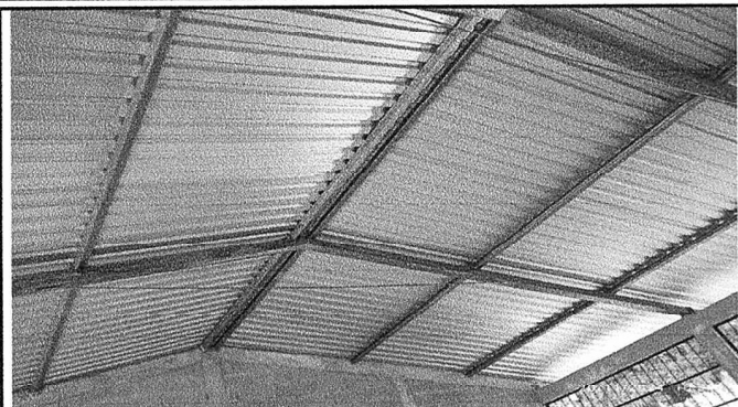
Foto1: Estructura metalica y entechado instalados del modulo 1.
