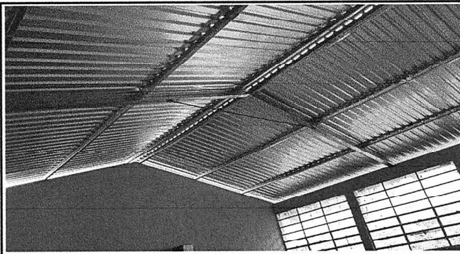
Foto 2: Estructura metalica y entechado instalados del modulo 2.
